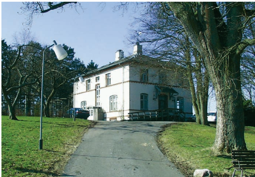
Overlægens bolig, Biskop Svanes Vej 52.
